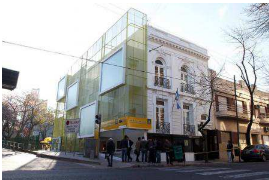
Edificio sede central de la Comuna Nº 3 en Junín 521
